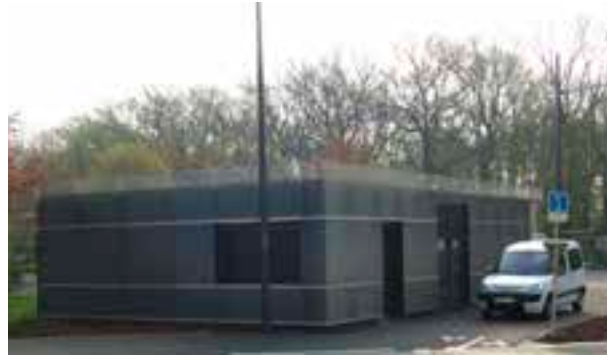
Omformerstation for kørestrøm.
