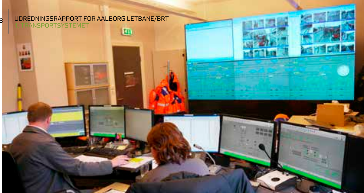
Kontrolcenter for letbanen i Bergen, Norge.
