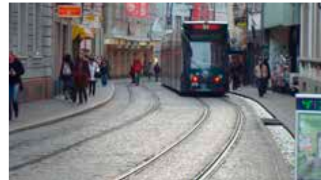
Letbanetracé med rilleskinner i brostensbelægning fra Freiburg, Tyskland.
