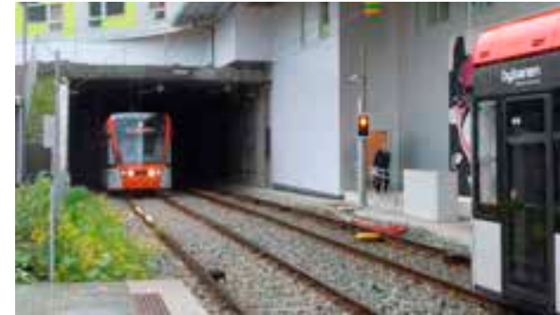
Letbanetracé med ballasteret spor i skærver fra Bergen, Norge.
