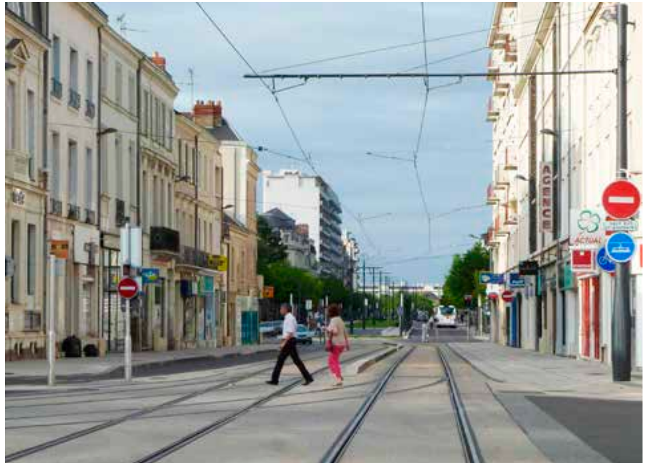
Masteophængt og facadeophængt kørestrømsanlæg fra Angers, Frankrig.
