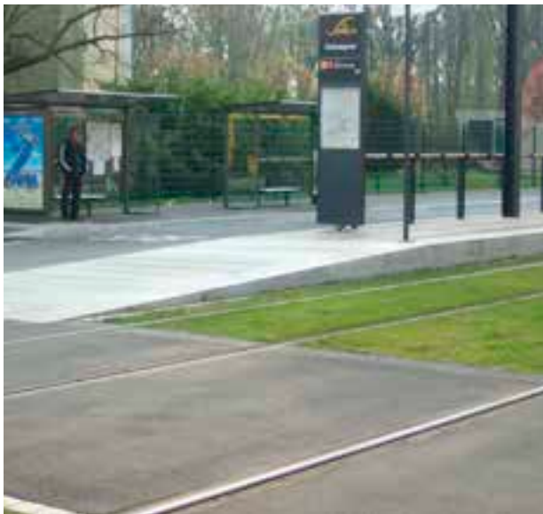
Rampe op til sidelagt perron ved et stoppested i Mulhouse i Frankrig.
